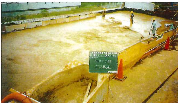
軽量性および土圧軽減を利用した橋台背面埋戻盛土
