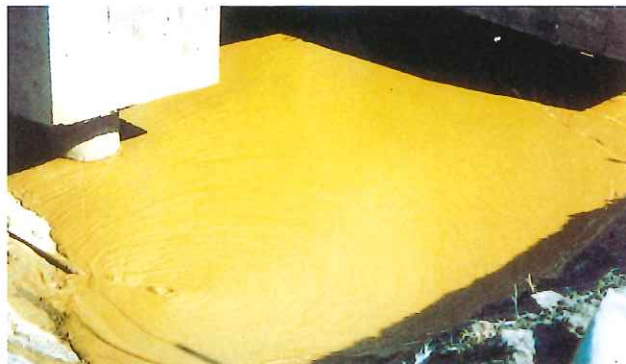
軽量性および土圧軽減を利用した橋台背面埋戻盛土
