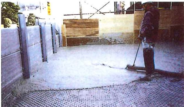
軽量性および流動性を利用した基礎下埋戻し工
