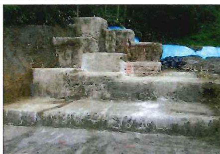
■改良体掘削後出来形
