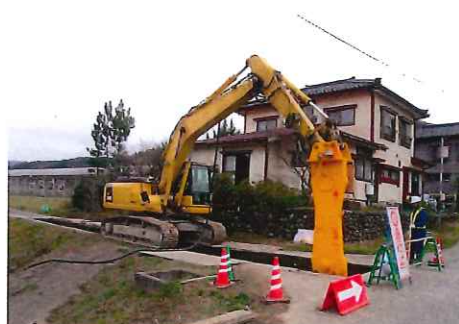
民家の近接部における改良施工
