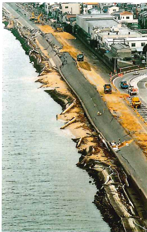
地震で大きく崩れた淀川最下流部の堤防 (阪神淡路大震災・読売新聞社提供)
