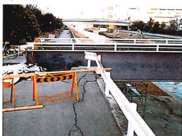
液状化による側方流動のため、 橋げたが道路部分に食い込んだ (阪神淡路大震災・読売新聞社提供)
