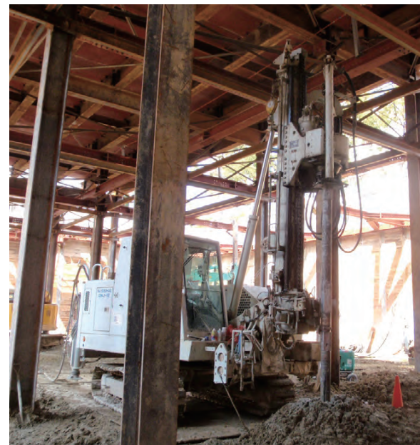
切梁下での施工状況
