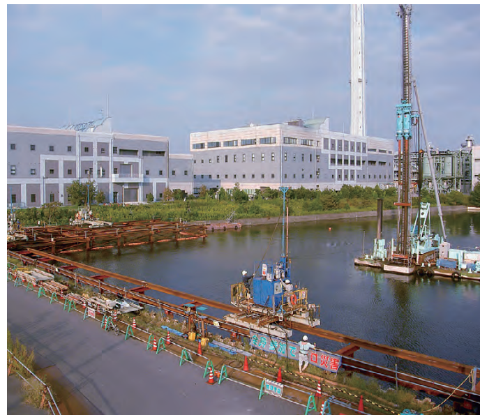
護岸耐震補強工事
