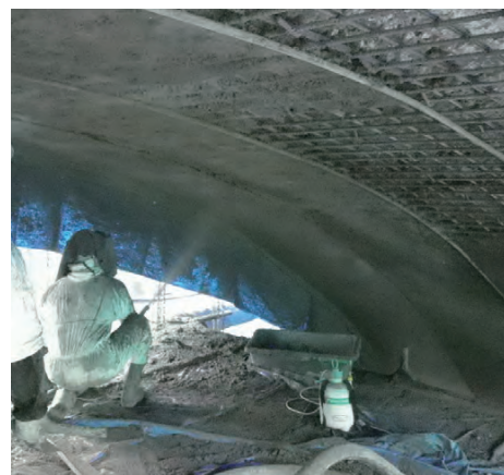
リフレドライショット施工状況
