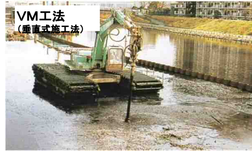
LVM工法 （長尺・垂直式施工法）
