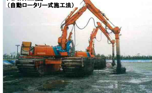
ARM工法 （自動ロータリー式施工法）
