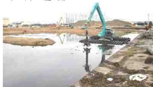
RM工法 （ロータリー式施工法）
