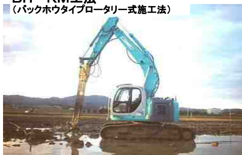
BH-RM工法 （バックホウタイプロータリー式施工法）
