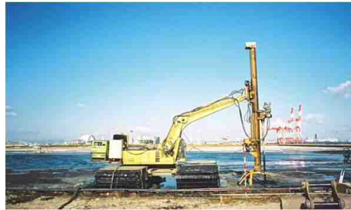
LVM工法 （長尺・垂直式施工法）
