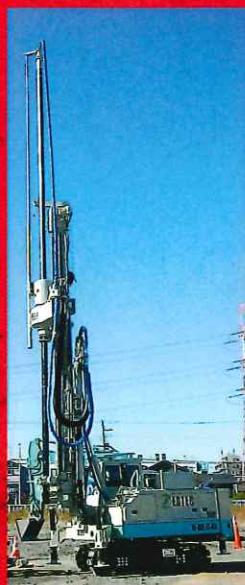
▲自走式機械(ミニ杭打機)施工
