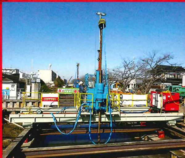
▲移動式架台(スライドベース)施工
