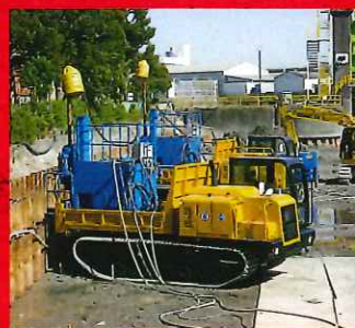
▲自走式機械(キャリアダンプ)施工
