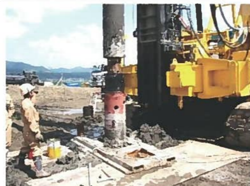
ロッド継足施工(最大50m)
