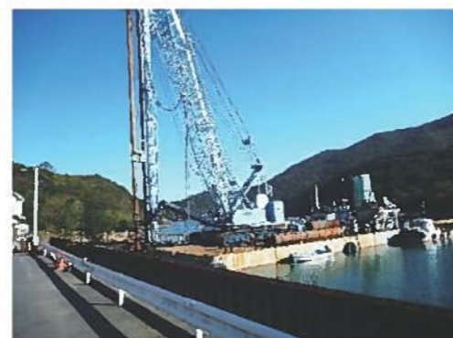
海上台船施工
