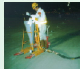
PC版下への裏込め注入
