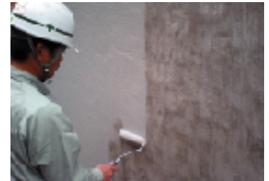
リフレベースW塗布状況 (ローラー施工)
