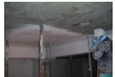
リフレベースW塗布状況 (リシガン吹付け施工)
