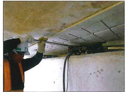
③ RMV 陽極設置溝切り
