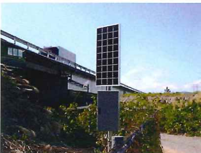
⑧ ソーラー電源設置
