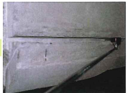
④ 陽極設置溝内 金属片探査
